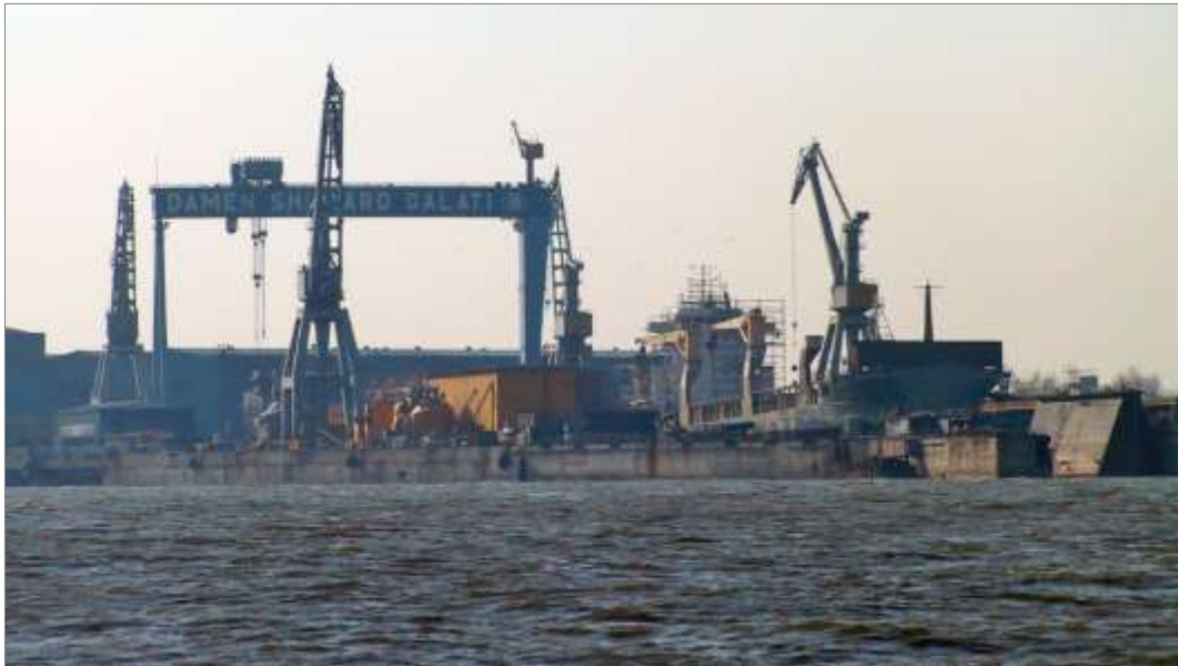
Figure 9 : Réparation navale dans le port de Galati, 2003.
