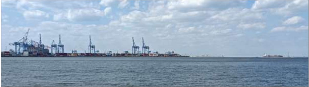
Figure 5 : Terminal à conteneur de Gdansk, 2021.
