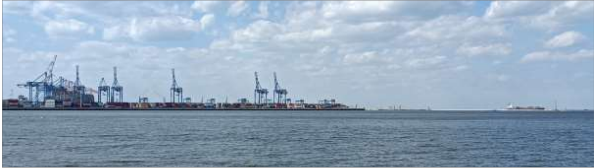
Figure 5 : Terminal à conteneur de Gdansk, 2021.
