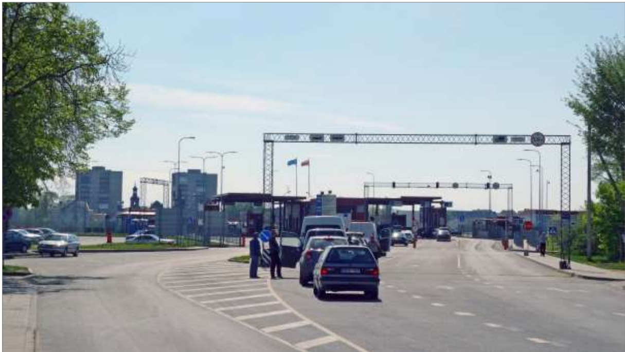
Figure 3 : Le poste-frontière de Panemune / Sovetsk, le 30 avril 2014.
