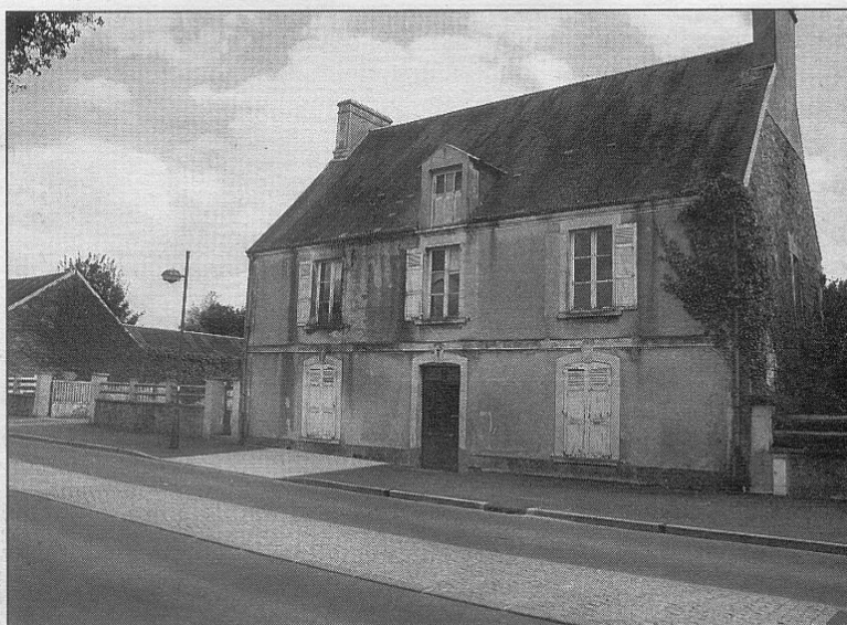
L'ancienne ferme constitue un site important pour l'entrée du bourg de Villers.
