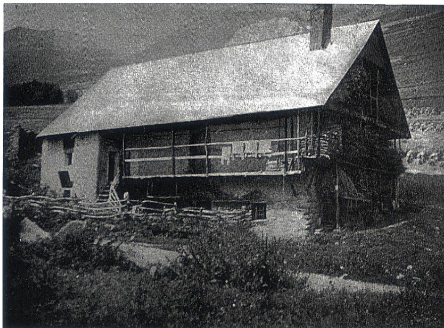
Planche II.B – Maison à cohabitation, type Saint-Sorlin-d'Arves (Maurienne). La tôle a remplacé le chaume.
