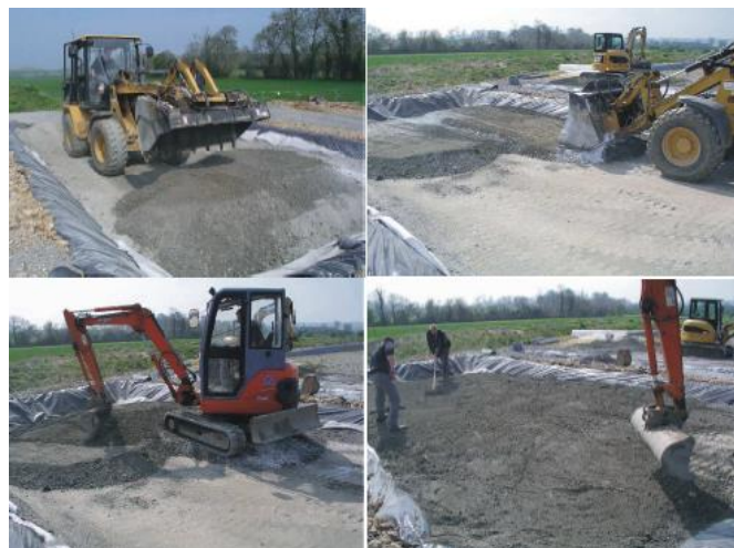
Figure 2-15. Mise en place des matériaux [Silitonga, 2010]
