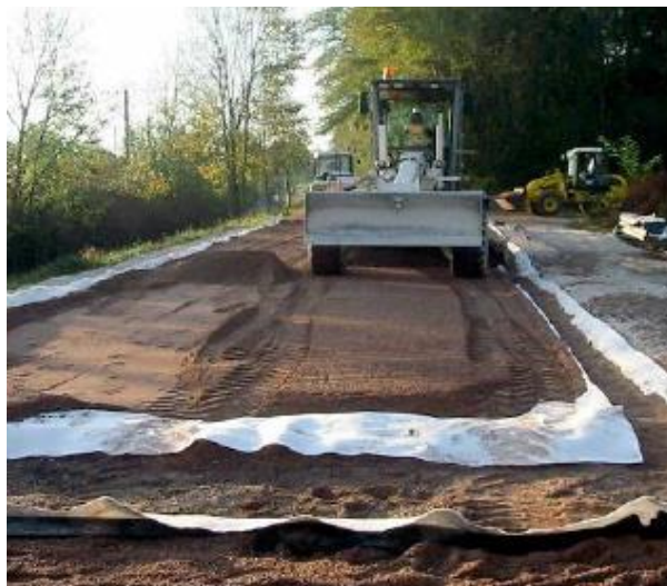
Figure 2-17. Construction de la route « test » [Depelsenair, 2007]
