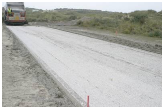
Figure 2-16. Mise en place de la plate-forme expérimentale dans le port de Dunkerque [Damidot et al. , 2006]
