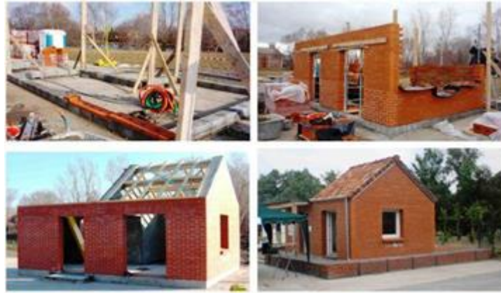
Figure 2-30. Construction d'une habitation témoin [El Fgaier et al. , 2013]
