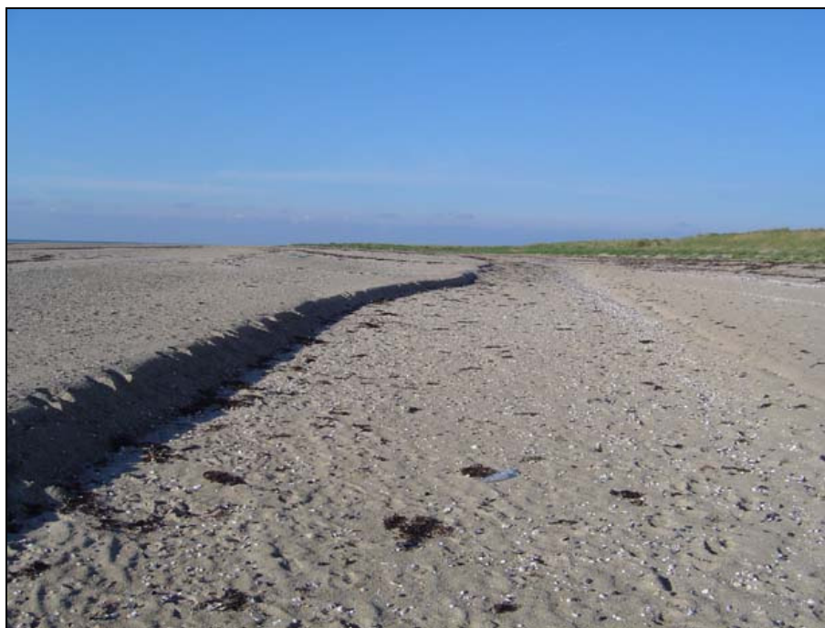
Figure 64: Barre de haut de plage vue côté terre en décembre 2004 au droit du profil 5.
