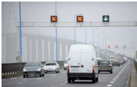
FIGURE 1 – Signalisation de voies dynamiques sur le pont de Saint-Nazaire en France. Crédit photo : Inconnu. Photo extraite du site : http://www.pau-circulation.fr/2010/09/innovatio-high-tech-du-pont-de-saint-nazaire/
