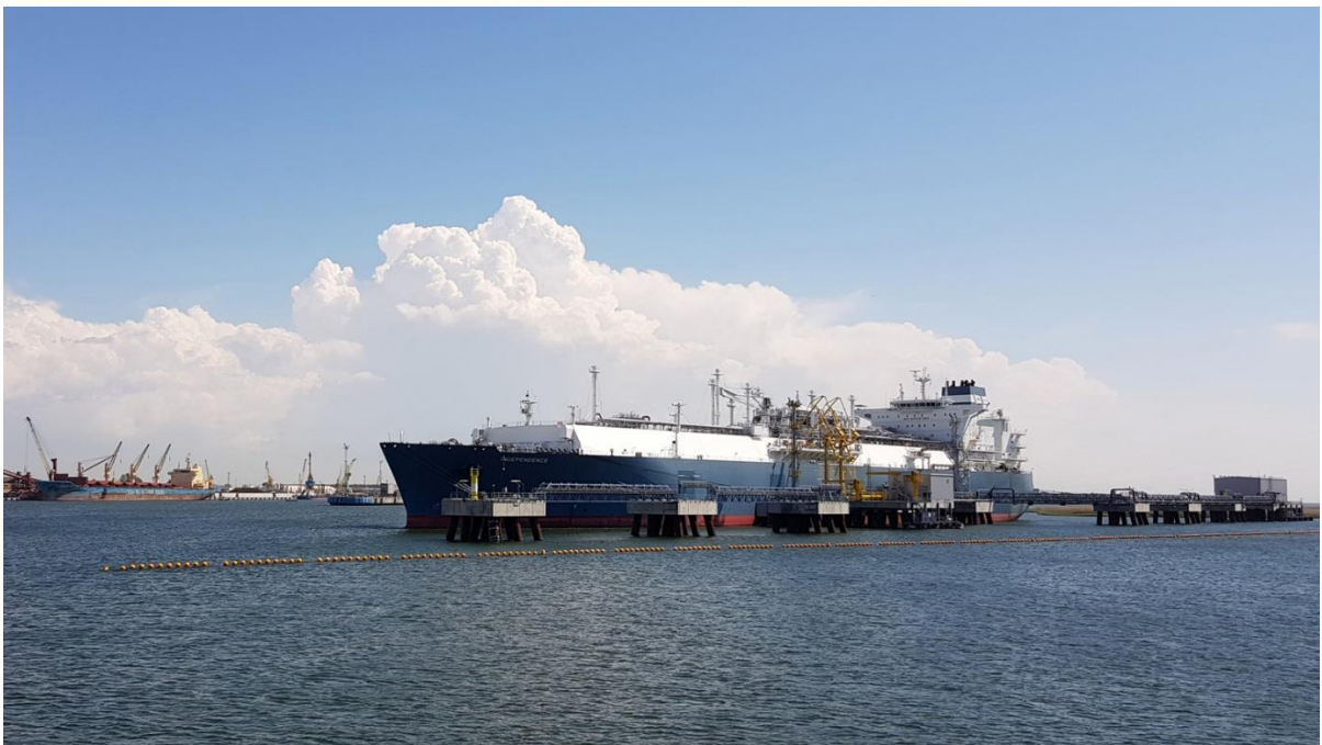
Figure 2 : Le terminal GNL « Indépendance » à Klaipėda
