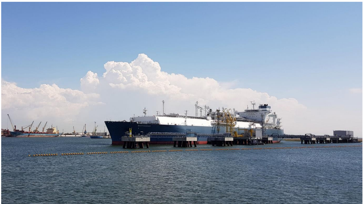
Figure 2 : Le terminal GNL « Indépendance » à Klaipėda
