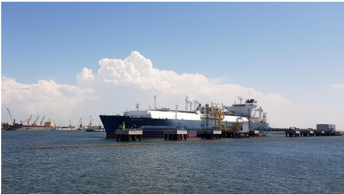
Figure 2 : Le terminal GNL « Indépendance » à Klaipėda
