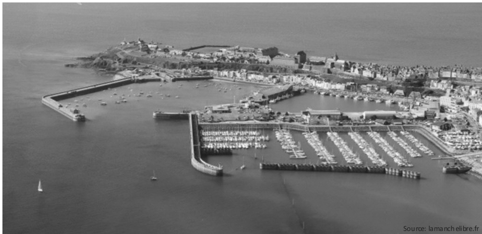
Figure 1 : Le port de Granville. Au premier plan, le port de plaisance ; à l'arrière, le bassin à flot ; à gauche, l'avant-port d'échouage.
