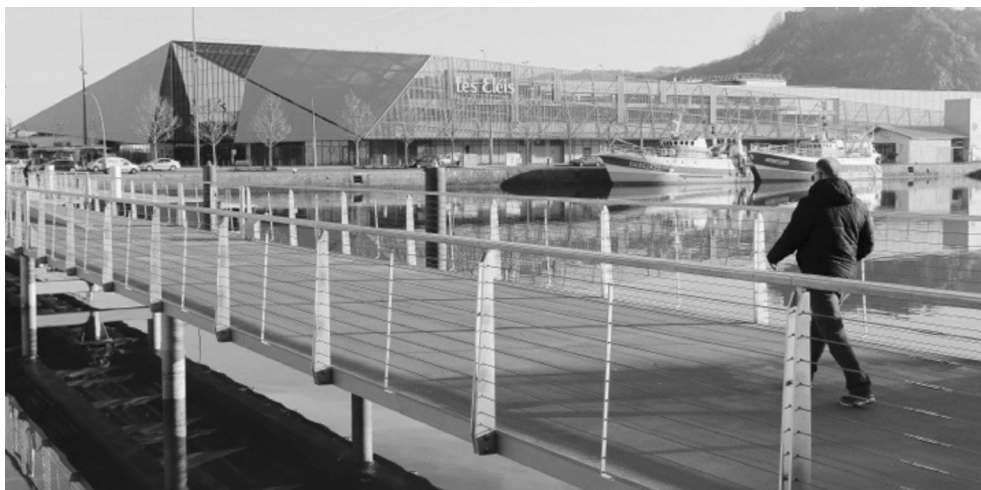
Figure 3 : Le centre commercial bordant le bassin de commerce et au premier plan la passerelle relevable
