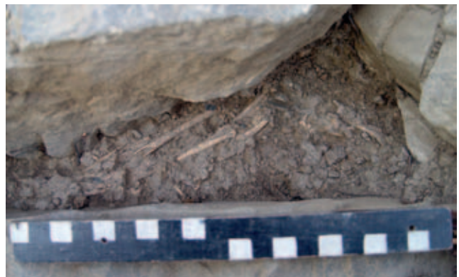
Рис. 1.57. Кости животных в кладочном растворе передней стены. Вид с северо-востока, сверху.
