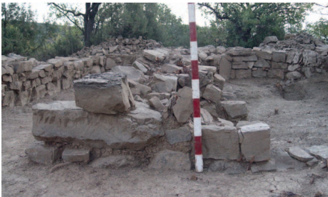
Рис. 1.17. Передняя стена южного компартимента. Фрагмент. Лицевой слой кладки фасада. Справа – откос проёма западного входа в храм. Вид с юго-запада. Fig. 1.17. Front wall of the southern part, fragment, front wall masonry, right - esconson of western doorway to the church, view from southwest.
