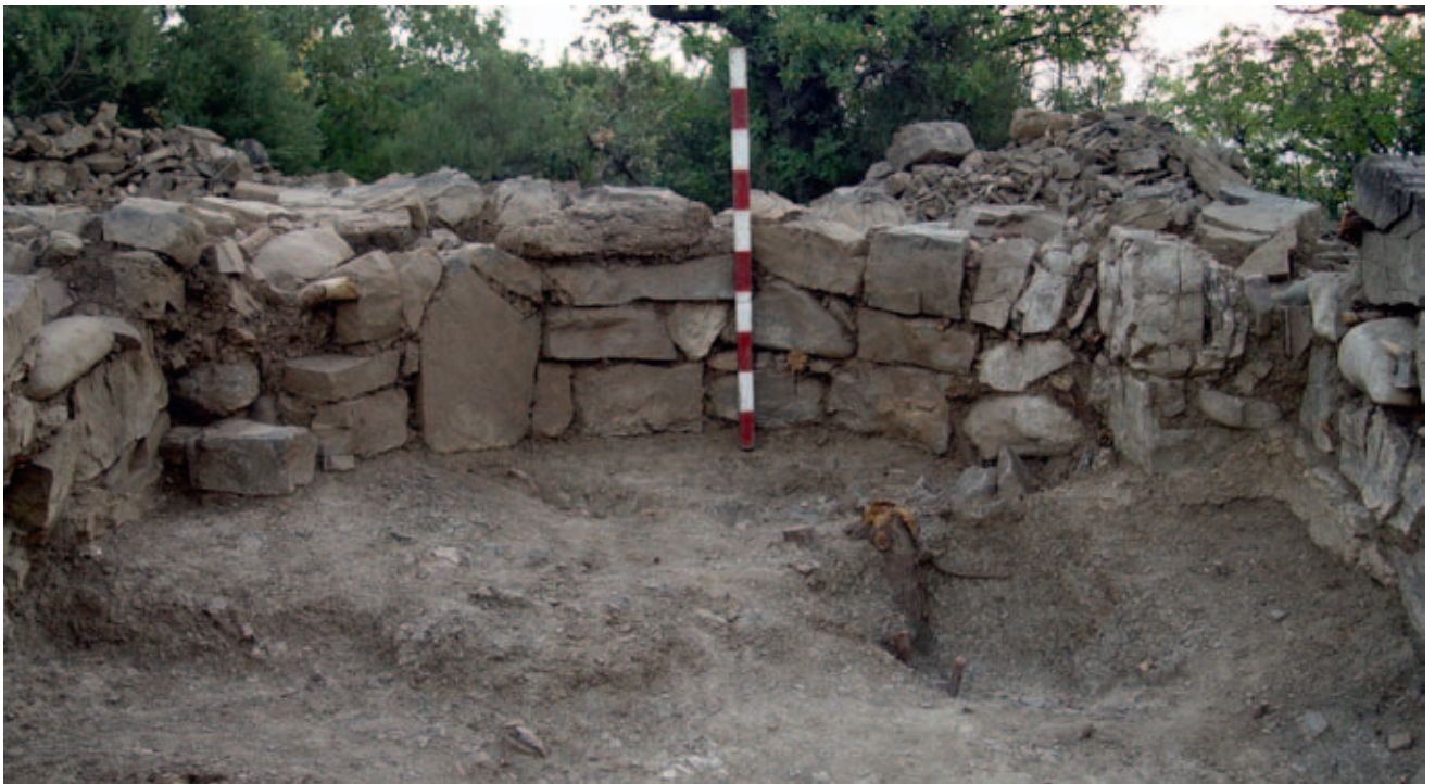
Рис. 1.11. Южная апсида. Южное заплечико первого строительного периода с остатками известковой штукатурки и лицевой слой кладки апсиды третьего строительного периода. Вид с юго-запада.
