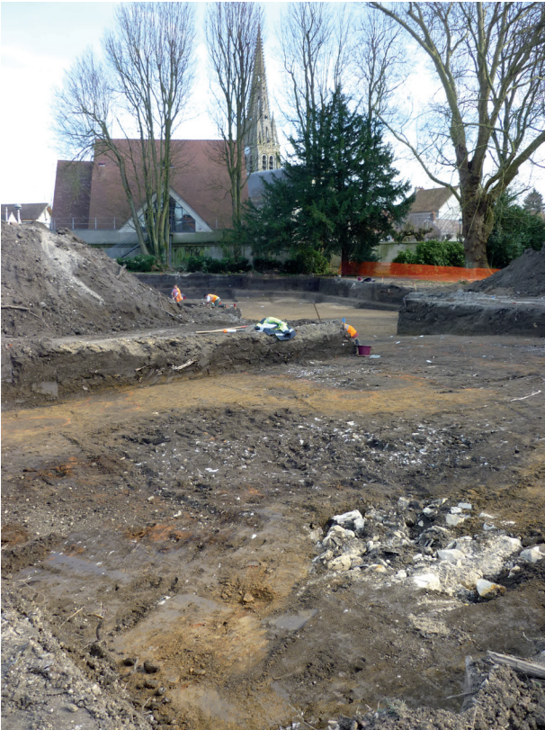
Fig. 3 - Vue du chantier (au premier plan) et de l'église Saint-Martin (au second plan).
