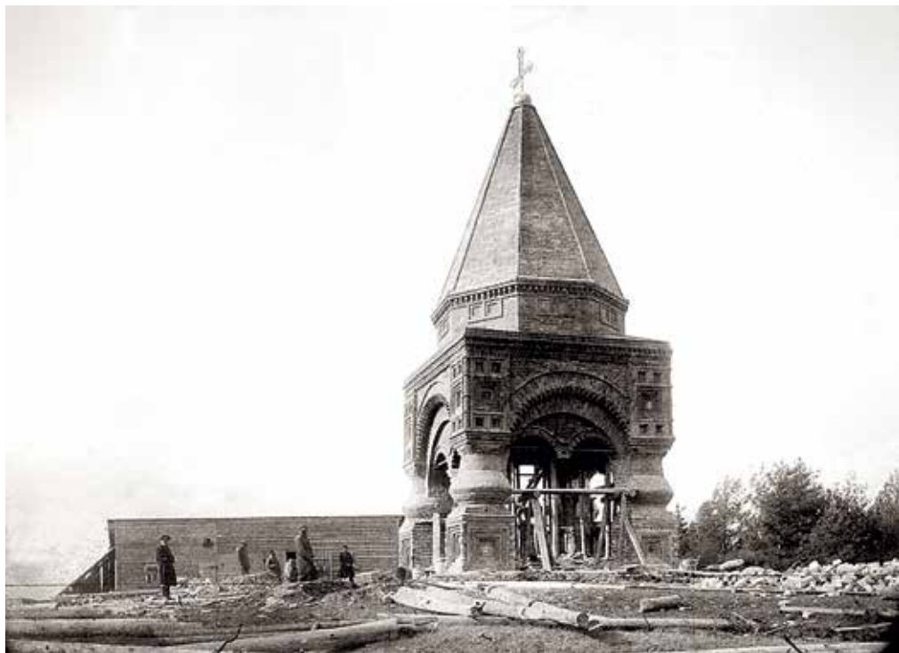
Часовня в Переславле-Залесском после реставрации, Владимирская губерния (РО. Ф. 1. Оп. 1-1886 г. Д. 63. Л. 78)
