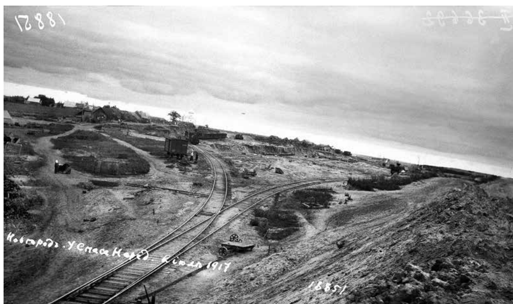
Строительство железной дороги у церкви Спаса на Нередице. Новгород. Фото П. П. Покрышкина, июль 1917 г. (ФО. Нег. II 39035)
