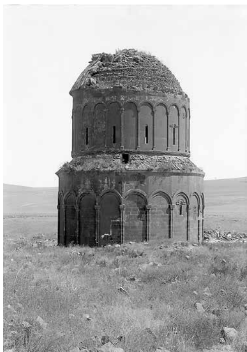
Ани. Церковь Спасителя после ремонта (ФО. Нег. II 43004)
