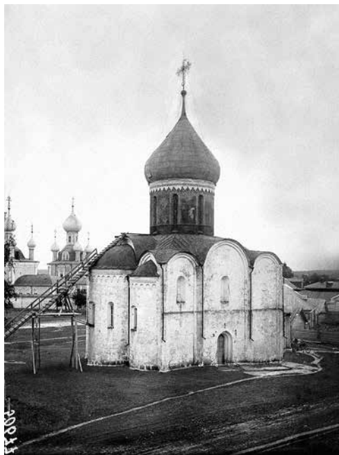
Собор Спаса Преображения, Переславль-Залесский, Владимирская губерния. Вид с северо-востока. Фото В. В. Сулова, 1880–1890-е гг. (ФО. Нег. II 14040)
