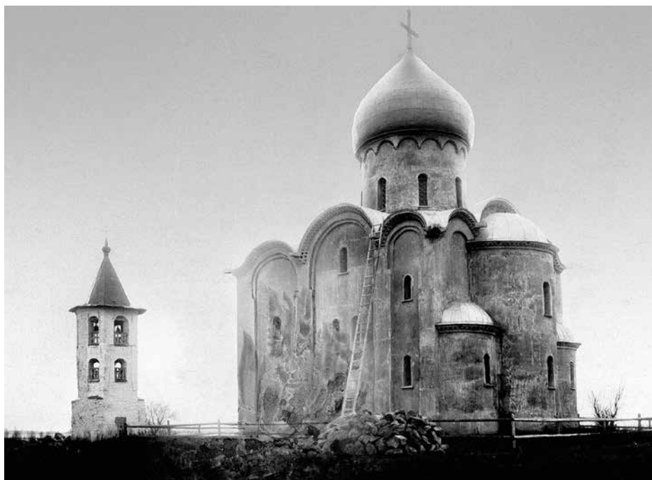
Церковь Спаса на Нередице под Новгородом до и после реставрации. Вид с юго-востока (ФО. Отп. О.623-2, отп. О.627-51)
