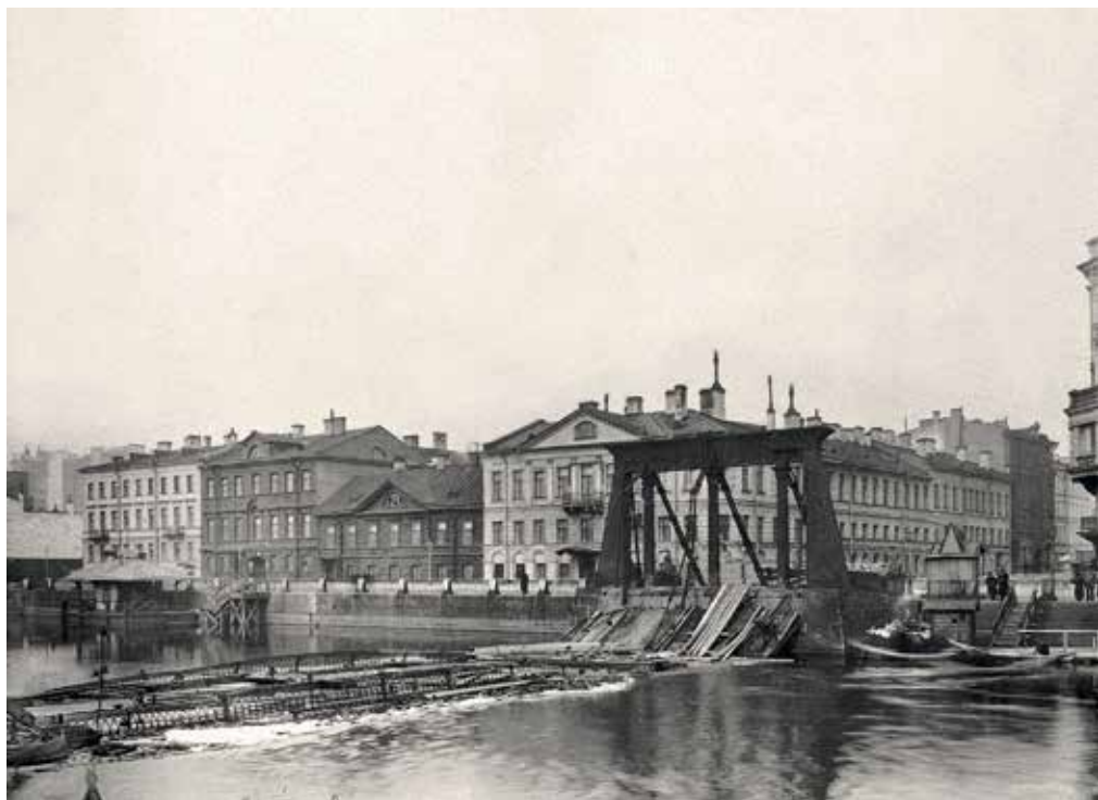
Египетский мост после обрушения, Санкт-Петербург, 1905 г. (ФО. Отп. О.1523-4)
