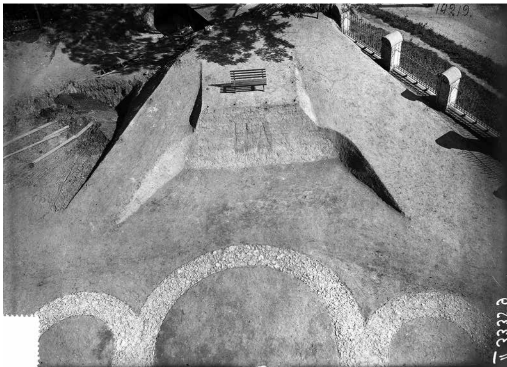
Трассировка фундаментов апсидной части Десятинной церкви, 1911 г. (ФО. Нег. II 33359)
