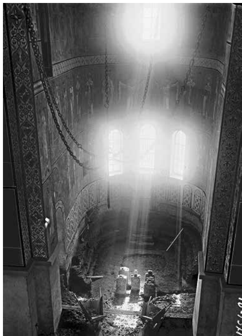
Софийский собор, Новгород. Внутренний вид во время реставрации. Работы В. В. Суслова, 1896 г. (ФО. Нег. II 3702)
