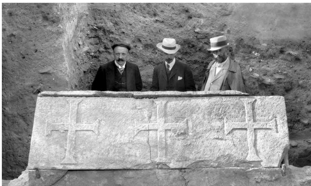
Шиферный саркофаг у северной стены Десятинной церкви, 1908 г., личности не установлены (ФО. Нег. II 86009)
