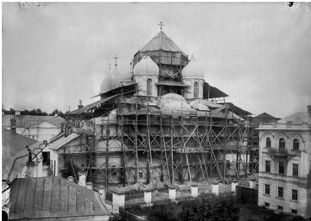
Софийский собор, Новгород. Общий вид во время реставрации. Работы В. В. Сулова, 1896 г. (ФО. Нег. II 3707)
