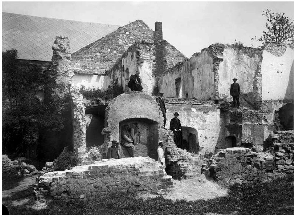
Костел св. Иакова в Сандомире во время реставрационных работ. Фото П. П. Покрышкина, май 1907 г. (ФО. Нег. II 28792)
