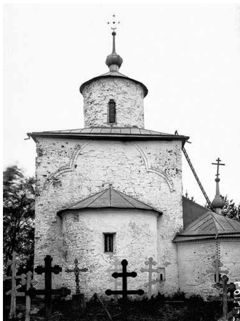
Церковь Успения на Волотове под Новгородом. Общий вид. Работы В. В. Сулова, 1894–1895 гг. (ФО. Нег. II 14184)
