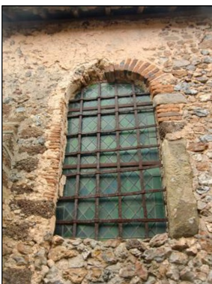
Fenêtre repercée au XIX e siècle. Des fragments d'une fenêtre de XII e siècle apparaissent à gauche avec des éléments d'un piédroit et d'un appui en grison
