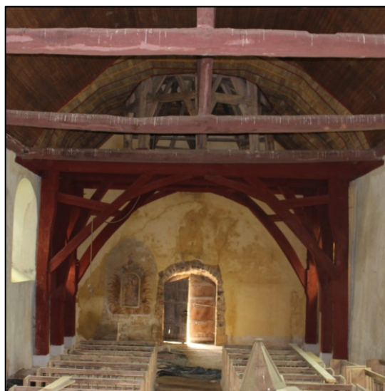
Portique et base du clocher
