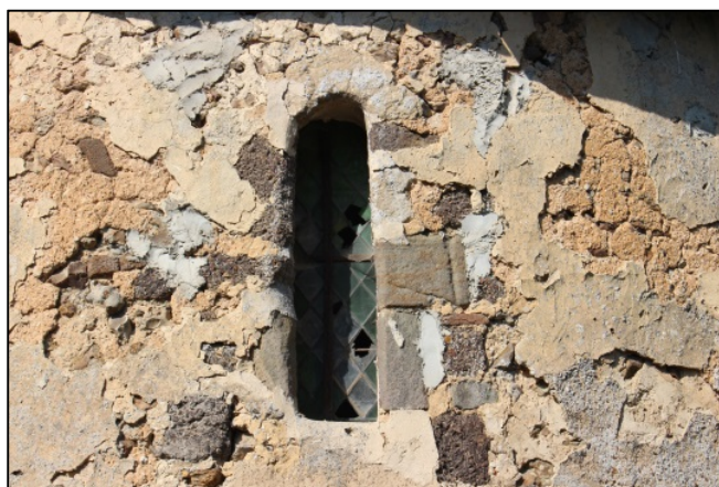
Baie romane axiale située au-dessus du contrefort central de l'abside. Cette fenêtre est surmontée d'un linteau monolithe gravé de faux claveaux
