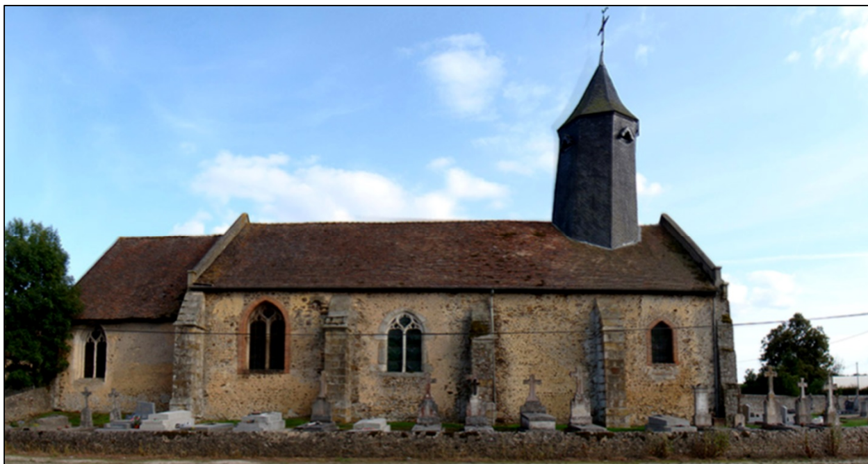
Vue générale de la façade nord de l'église
