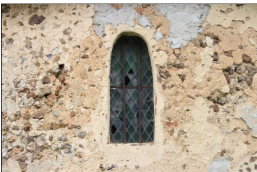
Baie romane axiale située au-dessus du contrefort central de l'abside. Cette fenêtre est surmontée d'un linteau monolithe gravé de faux claveaux
