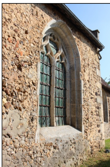
Fenêtre gothique tardive (XV e -XVI e siècle) percée dans le mur sud de la nef
