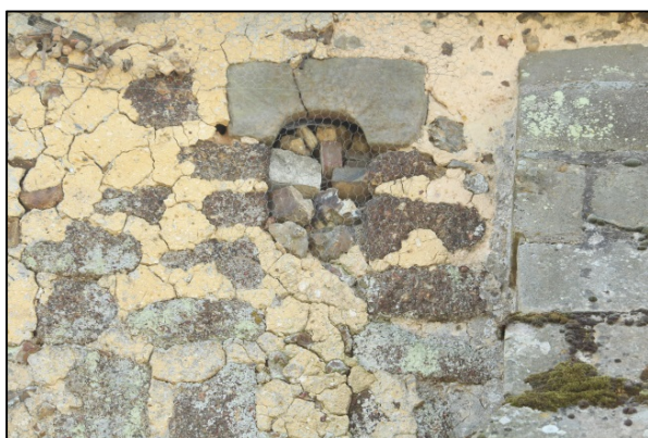
Baie romane sur le mur nord de la nef
