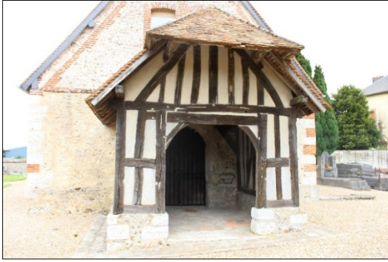
Porche en pan de bois sur une base maçonnée en silex construit en 1713
