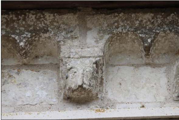
Mur est et sud du chevet, détail de la corniche et des modillons
