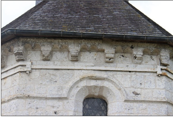
Mur est et sud du chevet, détail de la corniche et des modillons
