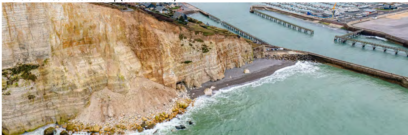
Effondrement de falaise à Fécamp (Seine-Maritime)
