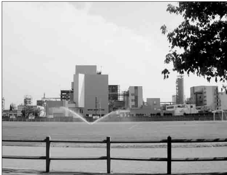
DR Le terrain de foot du stade de Pierre-Bénite et les ateliers de l'usine Atofina.
