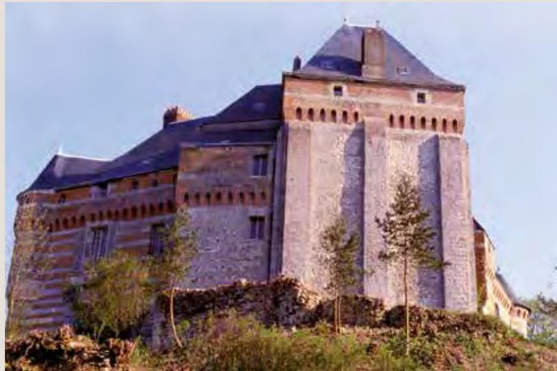
mité nord subsiste un donjon carré à contreforts plats, du XII<sup>e</sup> siècle. Haute d'environ 22 mètres avec la toiture et large d'une dizaine de mètres, cette tour imposante a des murs de 2,40 mètres d'épaisseur, construits en silex avec quelques assises disposées en épis ; les contreforts sont constitués d'un appareil de calcaire et de tuf (ill. 2). La partie ancienne de la tour comprend trois étages. Au niveau inférieur, elle com-
