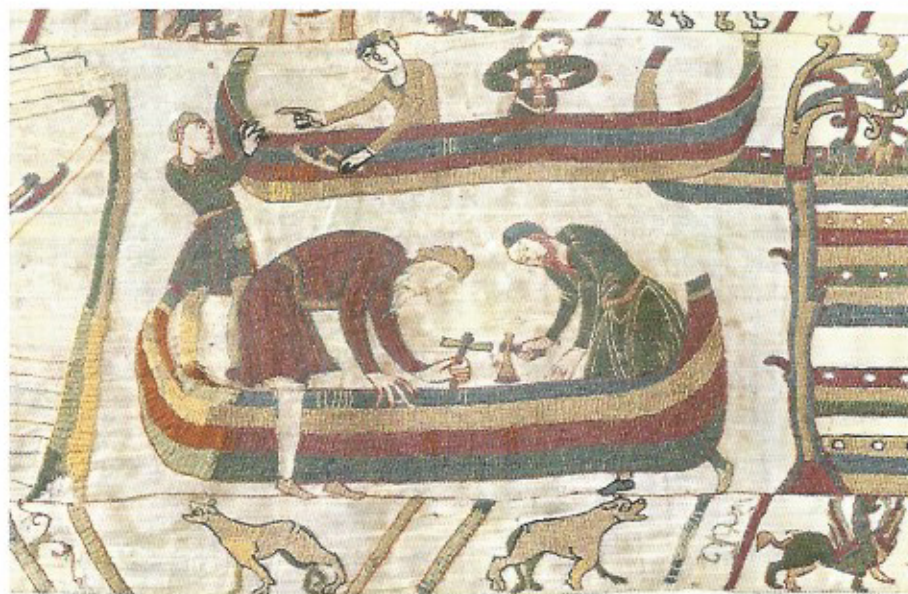
Fig. 1 Construction de la flotte ; deux charpentiers de navires au travail. Détails de la Tapisserie de Bayeux - XI e siècle.
