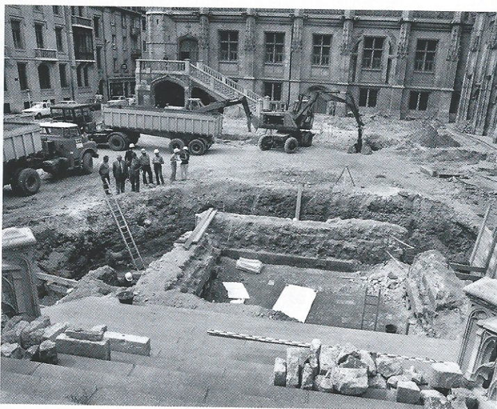
Fig. 1 : Été 1976, travaux dans la cour du palais de justice (cliché Inventaire)
