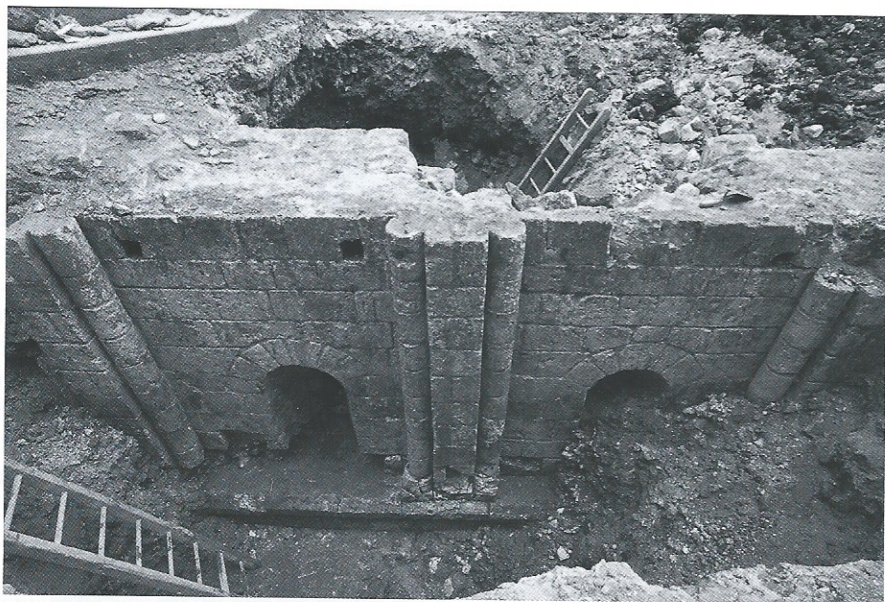
Fig. 2 : Apparition du mur nord du bâtiment (cliché Jean Vavasseur)
