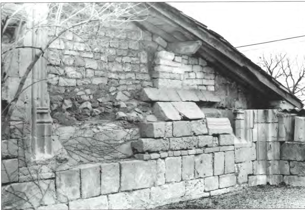
Fig. 47 : Melle : vestiges remontés de l'ancienne aumônerie de Fossemagne (n° 10) (Cliché : Inventaire général / A. Maulny, 1991 ©ADAGP).
