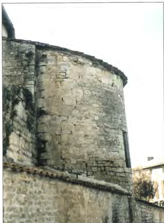
Fig. 43 : Melle, rue des Fossés : vestiges d’une tour de l’enceinte urbaine (n° 6d) (Cliché : L. Bourgeois).
