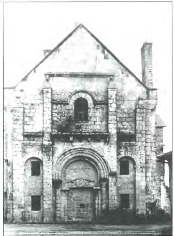
Fig. 46 : Melle : façade de l'église Saint-Savinien (n° 9) avant les restaurations de 1899-1901 (Cliché : Médiathèque de Poitiers / O. Neuillé).
