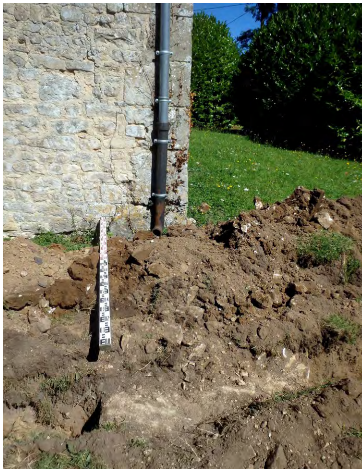
Illustration 36: Localisation du mur M01 dans l'axe du chevet de la chapelle
