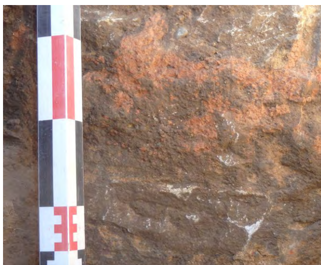
Illustration 38: Mur M01 parement est, détail de l'enduit
