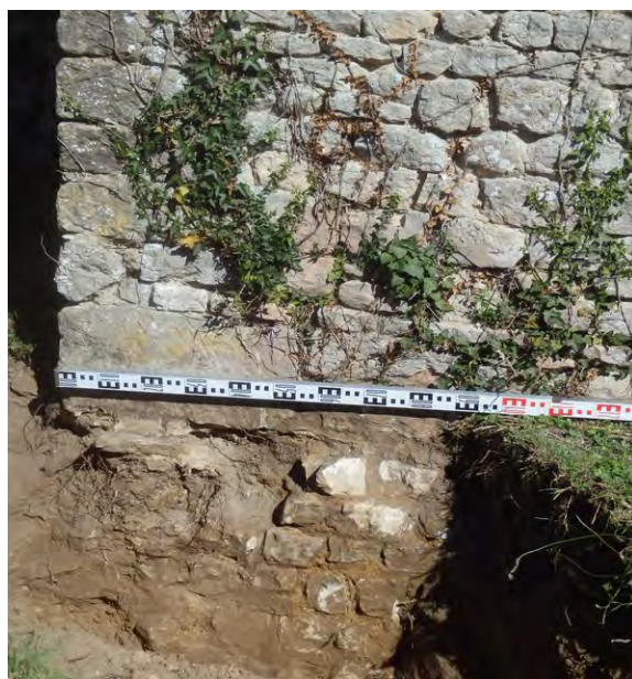
Illustration 40: Parement M02 sous l'angle sud-ouest de la chapelle sud du chœur
