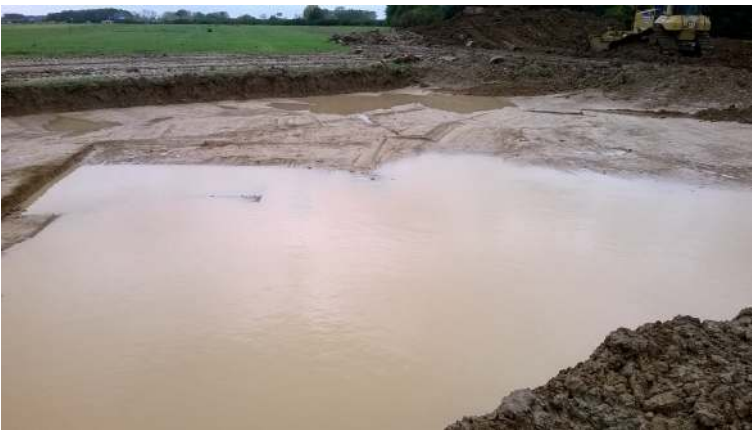
Fig. 4 – Vue de la partie sud de l'emprise en cours de décapage sous l'eau. Cliché : V. Brunet © Éveha 2013.
