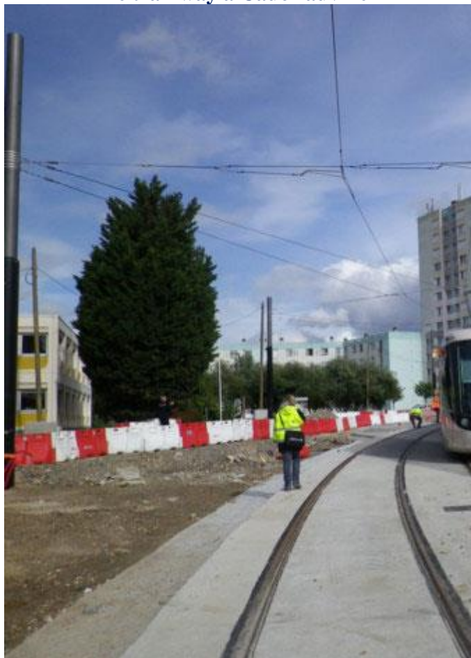
Premier essai du tramway en septembre 2012 Source : 76Actu
